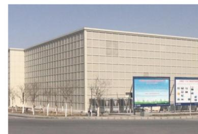
**中泰化学吐鲁番市托克逊县高性能树脂产业及配套基础设施建设项目，荣获中国建筑工程装饰奖公共建筑装饰类、建筑幕墙类。**建筑高度13.3米，为多层钢筋混凝土框架结构。深装集团承建该项目中央控制楼1-2楼、VCM机柜间室内外装饰及附属的单体外幕墙施工。深装集团以严格的过程质量控制，打造出弧形楼梯、中央控制室、外幕墙等关键亮点节点，并运用新型专利技术“一种节能保温型轻质隔墙结构”，实现隐私性、舒适性、多功能性的空间使用需求。
