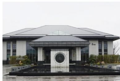
**中国银行股份有限公司安徽省分行培训中心，荣获中国建筑工程装饰奖公共建筑装饰类。**项目位于黄山市黄山区耿城镇，是供内部员工的教育、培训、娱乐等多功能一体式建筑。深装集团承建该项目的报告厅、食堂、宿舍楼E栋和倒班宿舍的装饰施工，现场施工采用铝蜂窝板3D打印以及精准的放样、排版，技术上运用新型专利技术“一种用于木饰面板的拼接结构”，提高施工效率，高质量完成工程建设任务。
